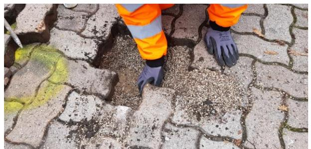
L'apertura delle Chiusure delle seriole ha permesso di comprenderne la conformazione e lo stato di conservazione in modo da integrarle nell'intervento di riqualificazione dello spazio pubblico. Attualmente queste non sono correttamente mantenute e risultano invase da plastica e rifiuti.
